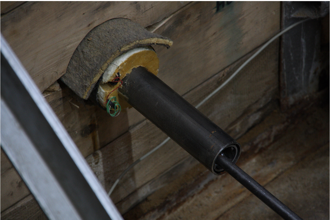
Bild 71 Beginn des Ausrückens von Mediumrohr und Wärmedämmung zum Ende des Bohrvorgangs hin
