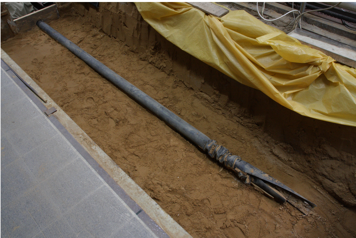
Bild 86 freigelegte Ummantelung mit darin fest sitzendem neuen Schlitz- und Aufweitkopf und daran angeschlagenem Seil des Seilzug-Wegensors
