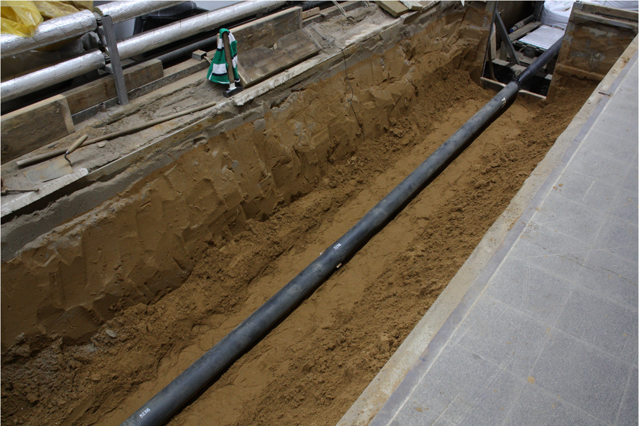
Bild 59 freigelegte Ummantelung des alten ausgebohrten KMR einschließlich der eingezogenen Teile
