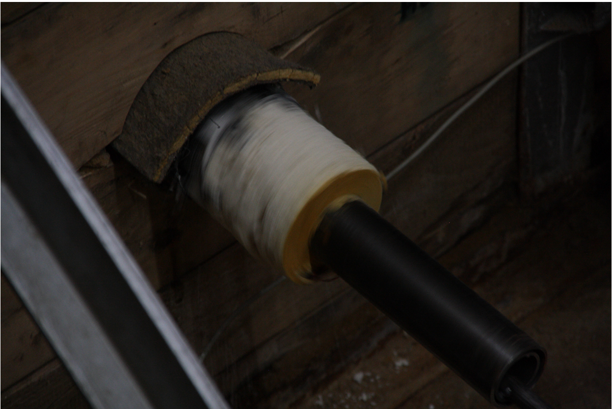
Bild 72 Rotation von Mediumrohr und Wärmedämmung zum Ende des Bohrvorgangs hin
