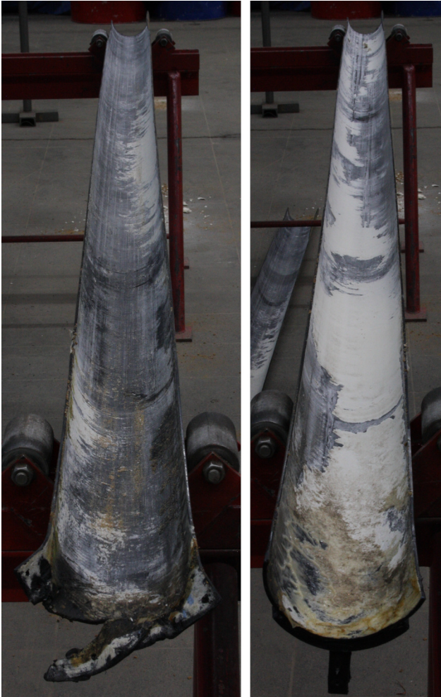
Bild 63 untere Halbschale (links) und obere Halbschale (rechts) des geschlitzten Teils der Ummantelung des alten ausgebohrten KMR
