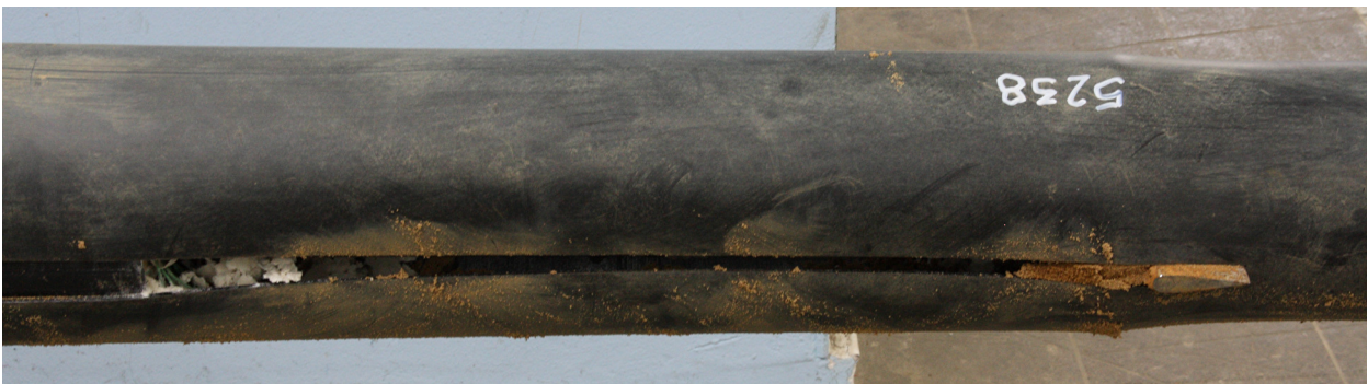
Bild 62 Blick durch einen der beiden Schlitz in den ausgebohrten Raum zwischen Schlitz- und Aufweitkopf und Stirnseite des neuen KMR
