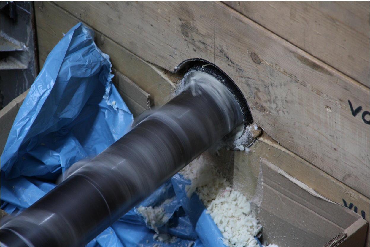
Bild 69 vollständiger Eintritt des Bohrkopfes in die Ummantelung
