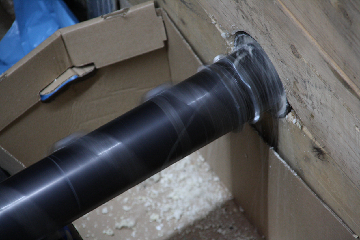
Bild 43 vollständiger Eintritt des Bohrkopfes in die Ummantelung
