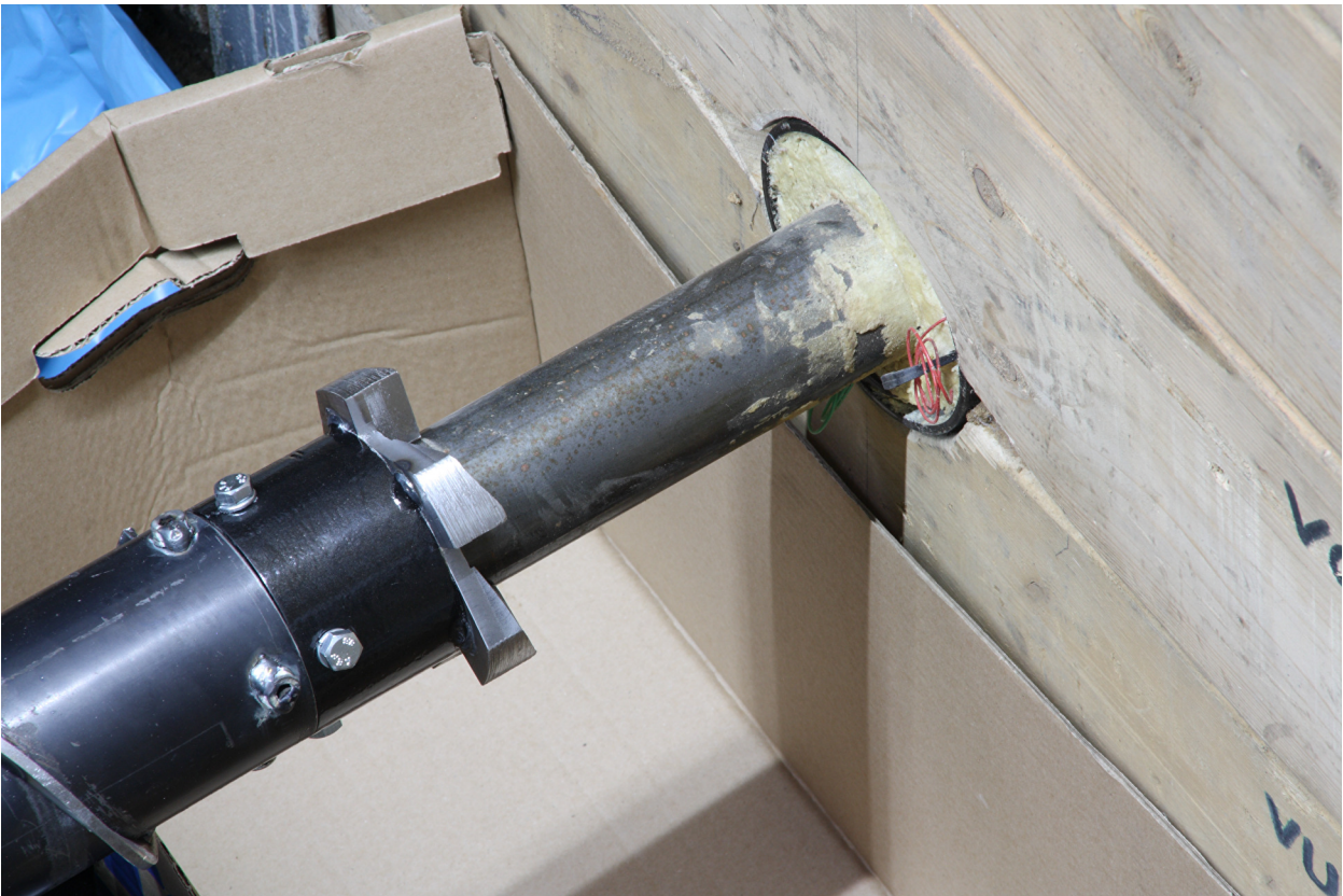
Bild 40 Bohrkopf über dem freien Mediumrohrende des alten KMR
