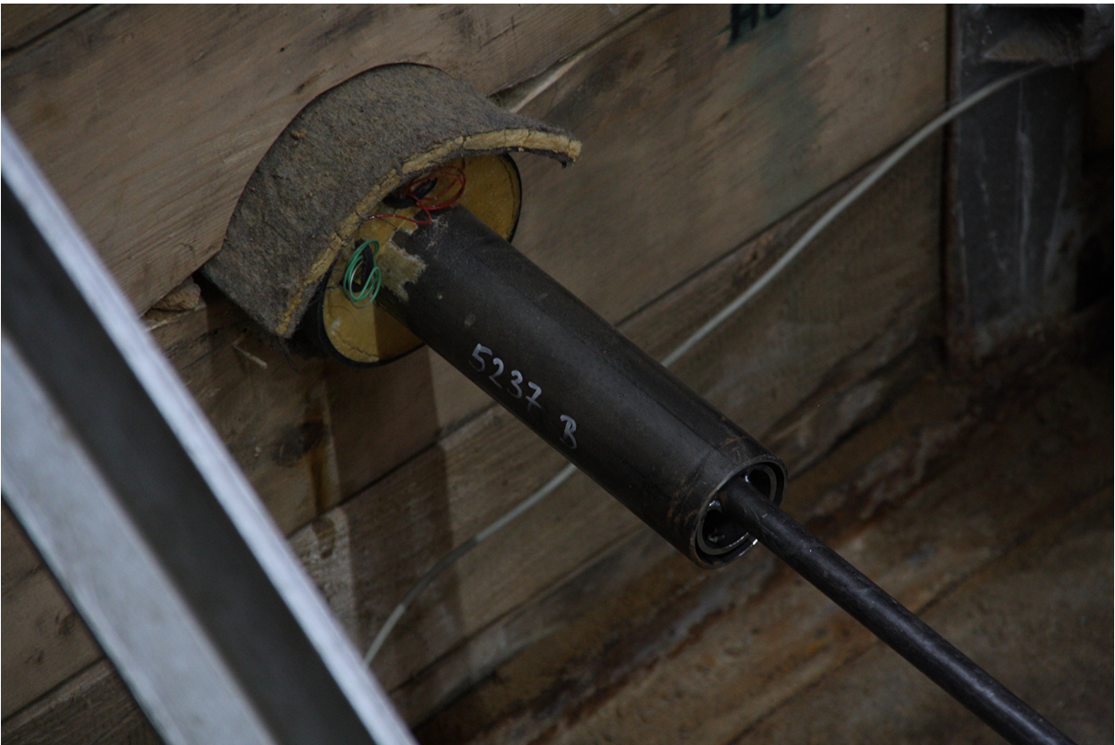
Bild 70 KMR-Ende in der Zielgrube, zu Beginn des Bohrvorgangs
