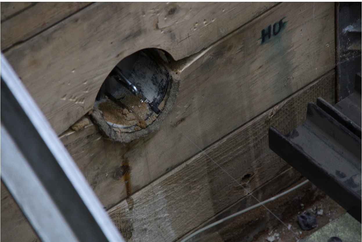
Bild 81 vollständiger Eintritt des Schlitz- und Aufweitkopfes in die Ummantelung
