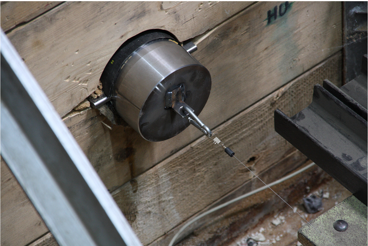
Bild 80 Beginn des Aufweitens der Ummantelung
