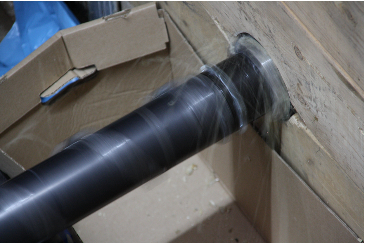
Bild 42 Eintritt des Bohrkopfes in die Wärmedämmung
