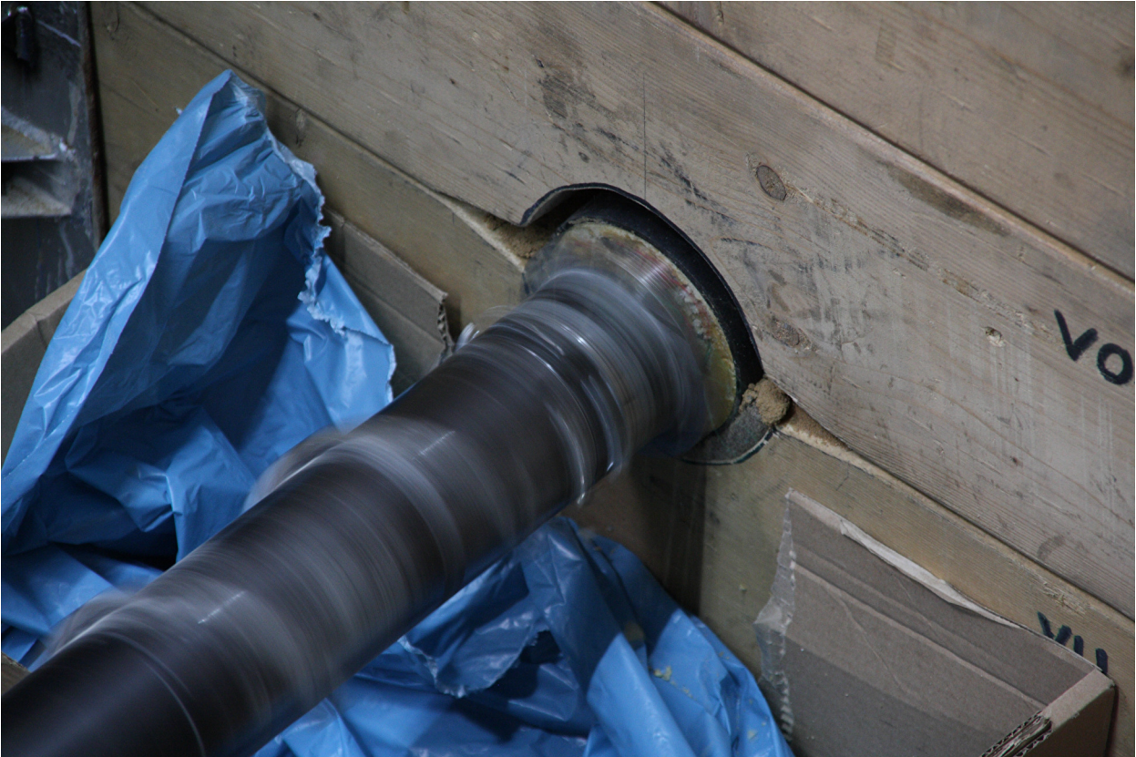
Bild 68 Eintritt des Bohrkopfes in die Wärmedämmung
