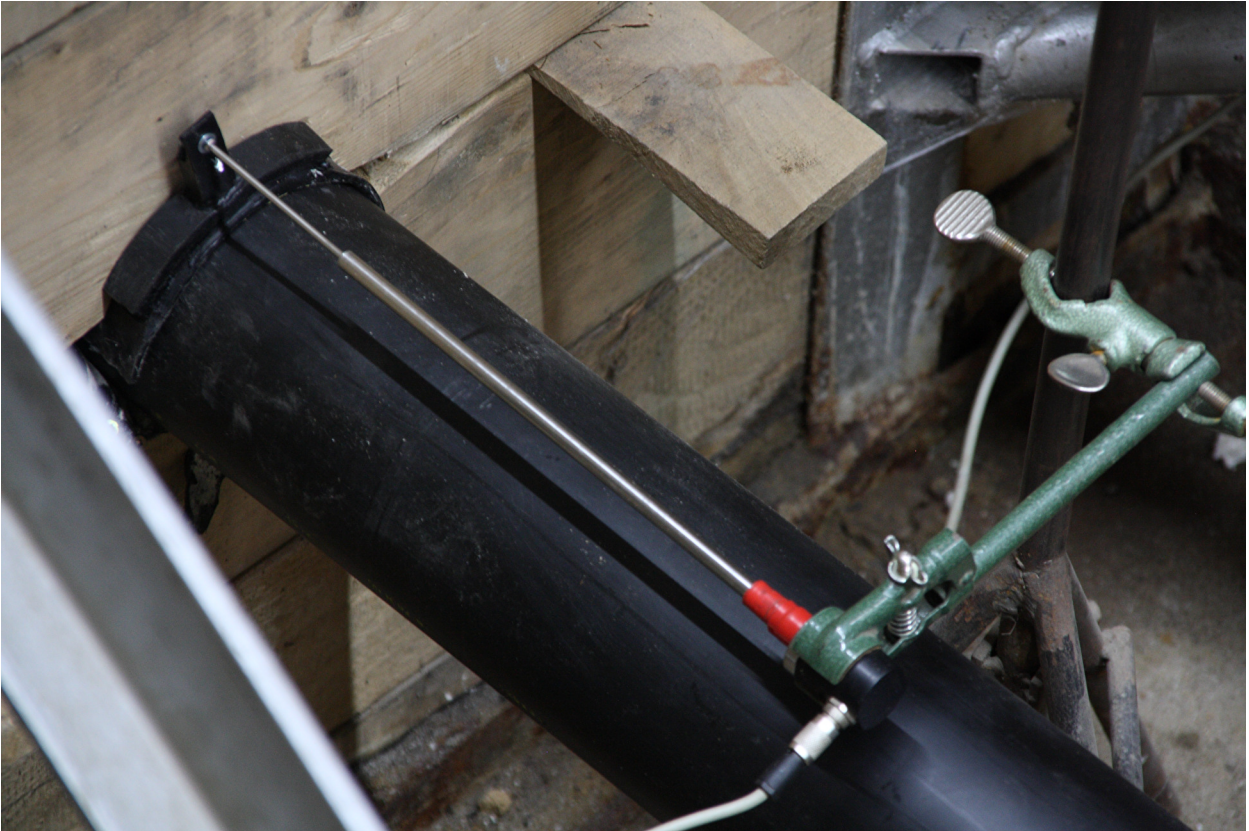
Bild 55 Eintritt der Ummantelung des neuen KMR in die Ummantelung des alten ausgebohrten KMR
