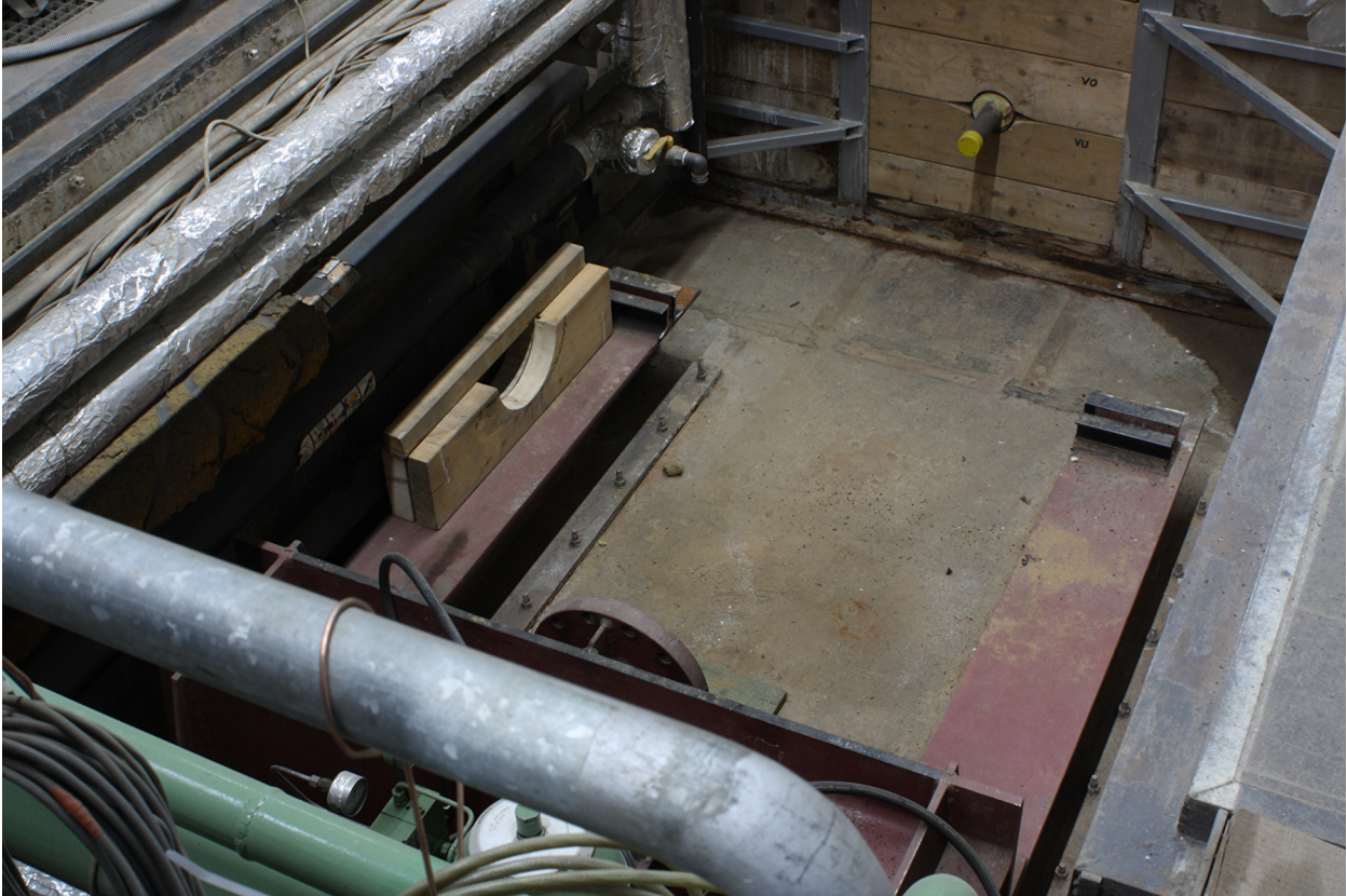
Bild 8 Einsatzort für die Bohreinheit der Bohranlage im Technikum, in der Spundwand Stirnseite des auszubohrenden KMR
