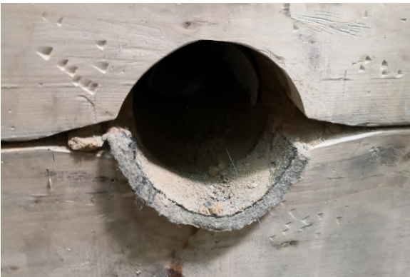
Bild 83 in die Bettung eingerückte Ummantelung
