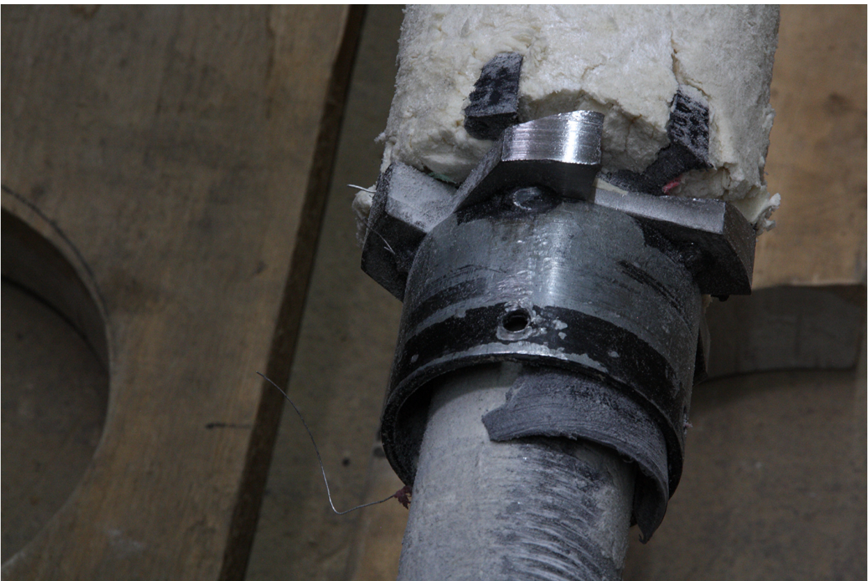
Bild 73 Bohrkopf auf dem Mediumrohr, nach Ende des Bohrvorgangs und Trennung vom Bohrgestänge
