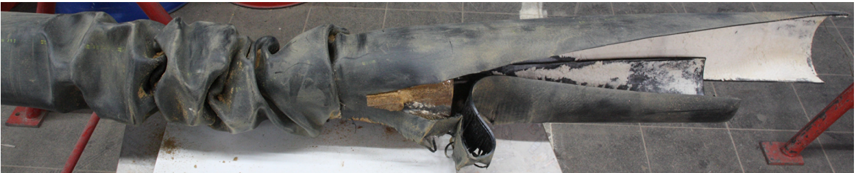
Bild 88 aufgefalteter Bereich der Ummantelung (links) vor dem neuen Schlitz- und Aufweitkopf (mittig) und in die Bettung eingerückte Bereiche der Ummantelung (rechts)
