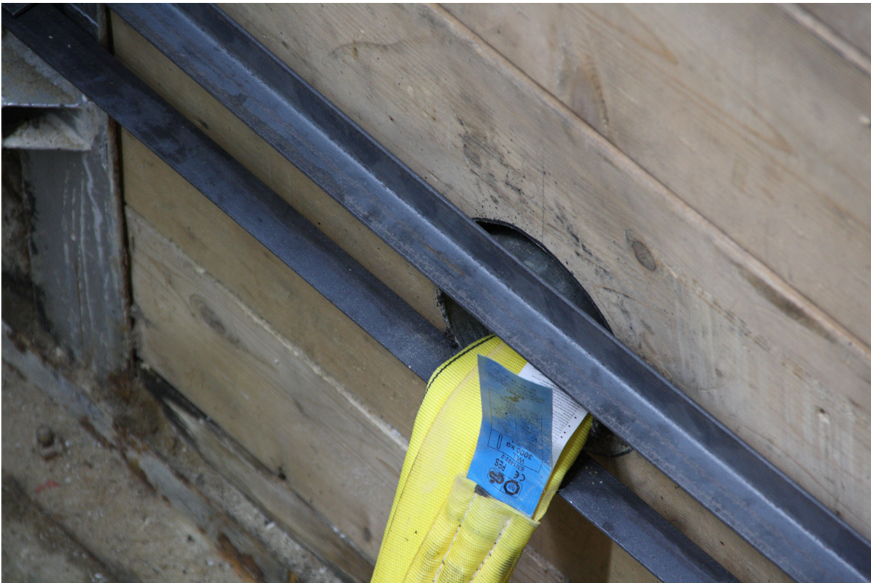
Bild 84 angeschlagene L-Profile gegen weiteres Ausrücken der Ummantelung
