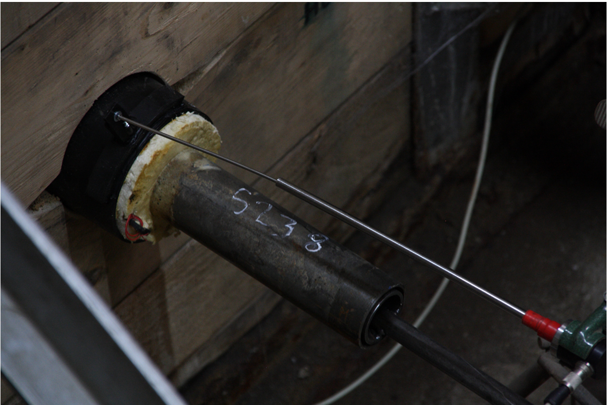
Bild 46 Beginn des Ausrückens von Mediumrohr und Wärmedämmung zum Ende des Bohrvorgangs hin
