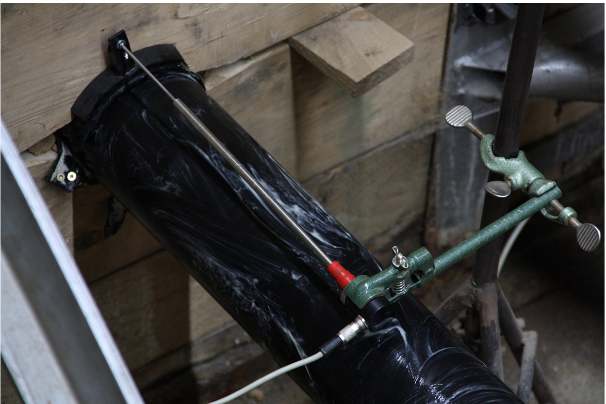
Bild 56 Auftrag von Kabelgleitmittel auf die Ummantelung des neuen KMR
