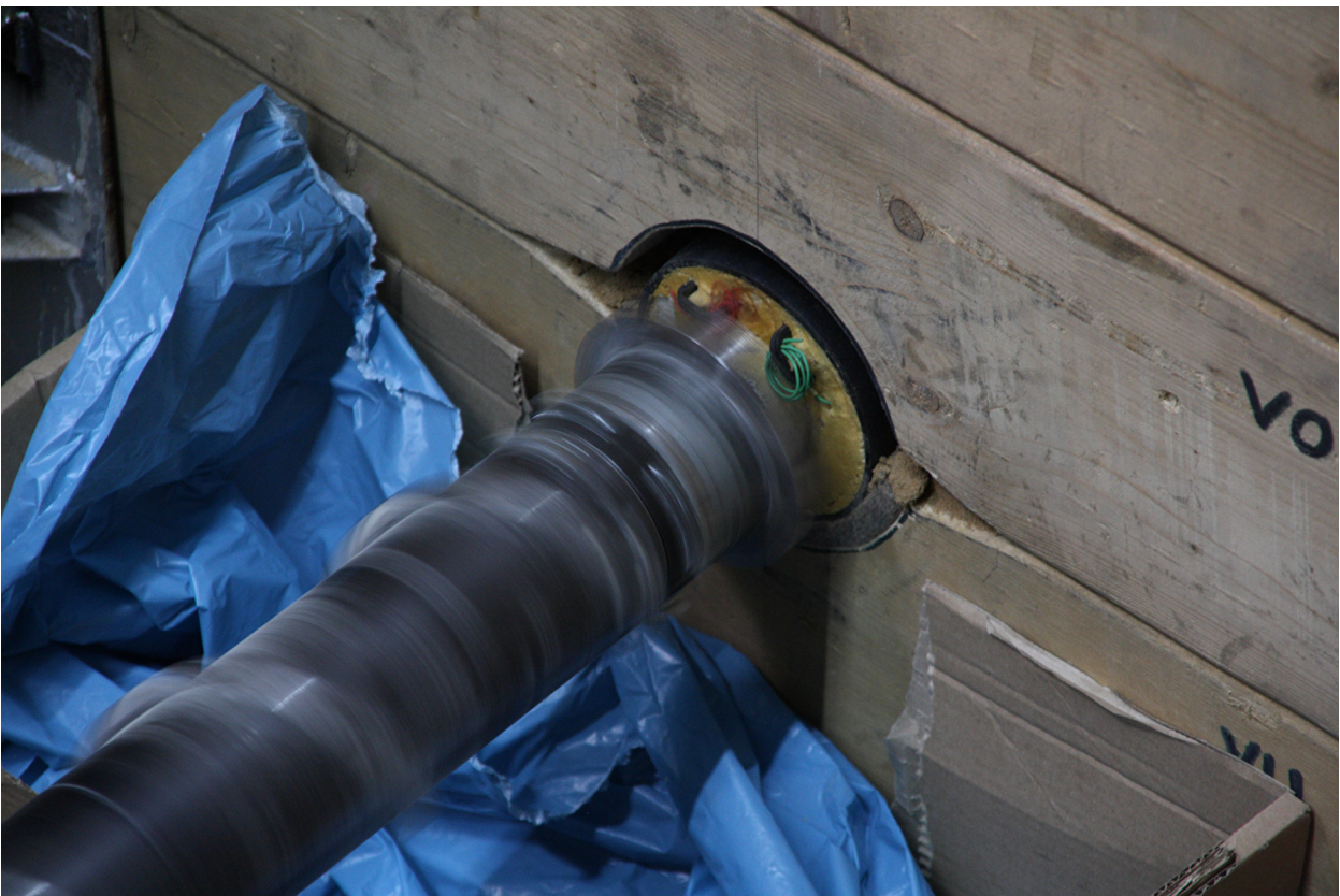
Bild 67 Beginn des Bohrvorgangs
