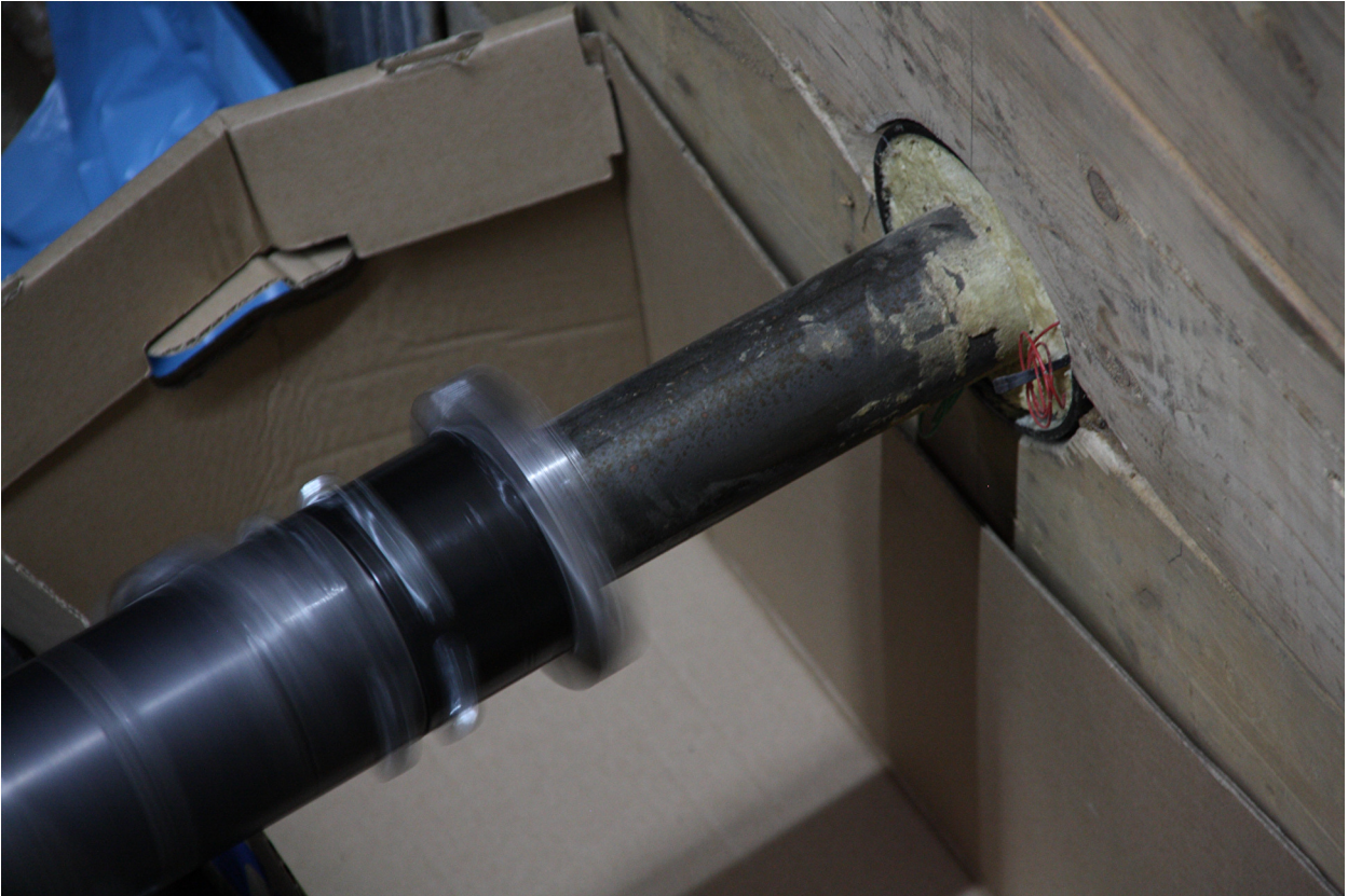
Bild 41 Beginn des Bohrvorgangs
