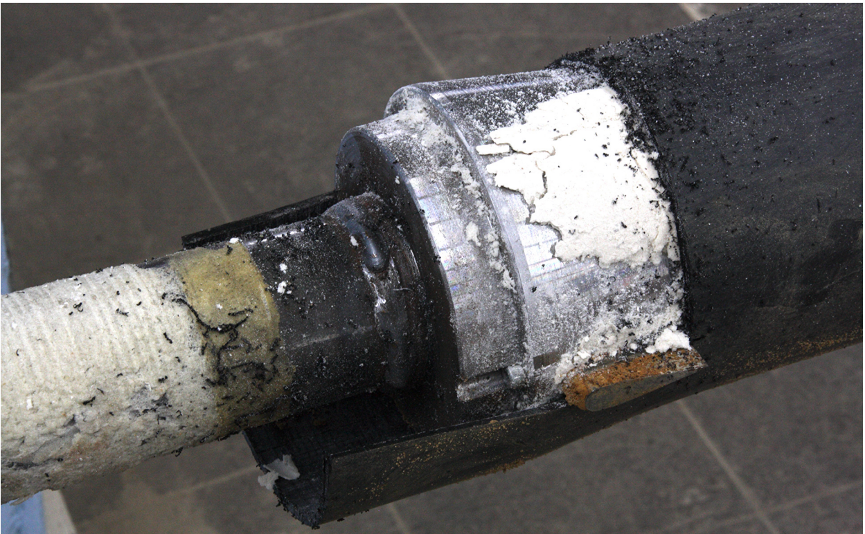
Bild 64 Schlitz- und Aufweitkopf, nach Entfernung einer Halbschale der ausgebohrten Ummantelung des alten KMR
