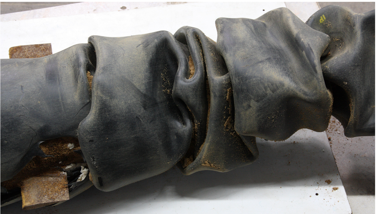
Bild 89 aufgefalteter Bereich der Ummantelung vor dem neuen Schlitz- und Aufweitkopf, im Graben oben gelegen
