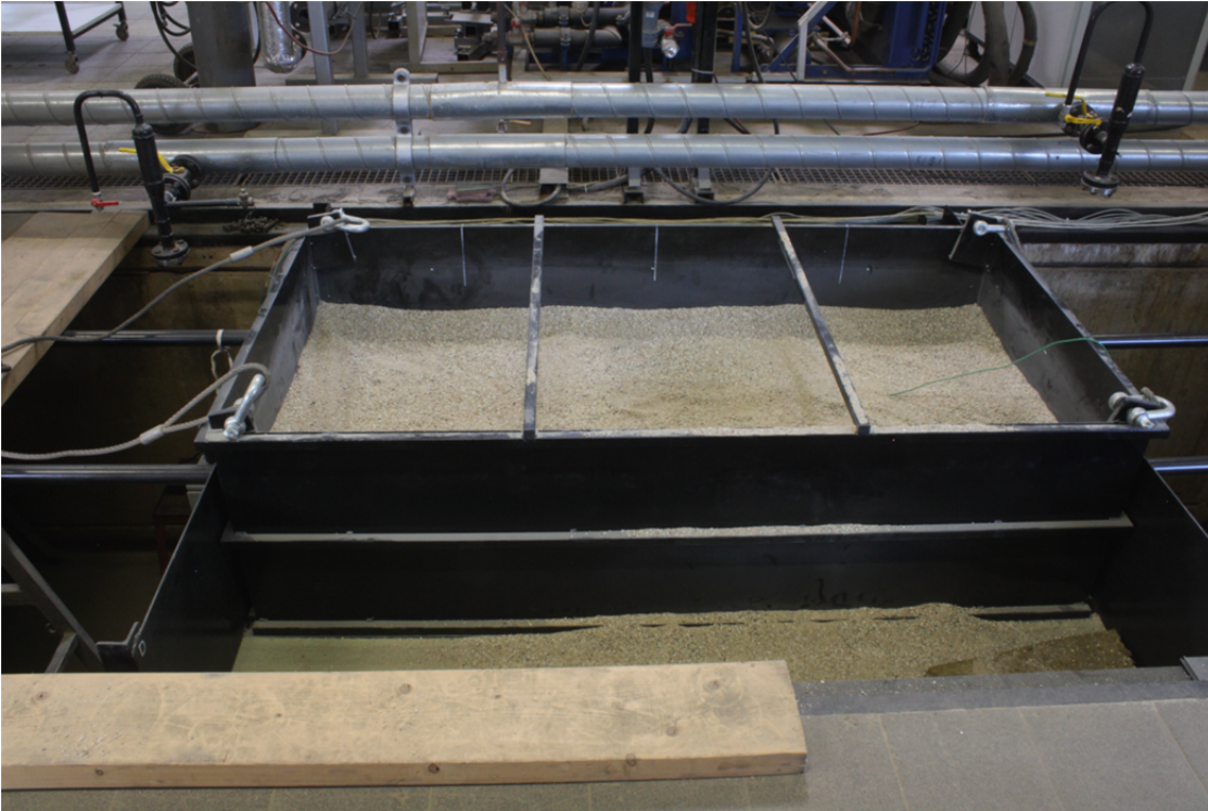
Bild 50 Graben mit Überdeckung während einer Messung
