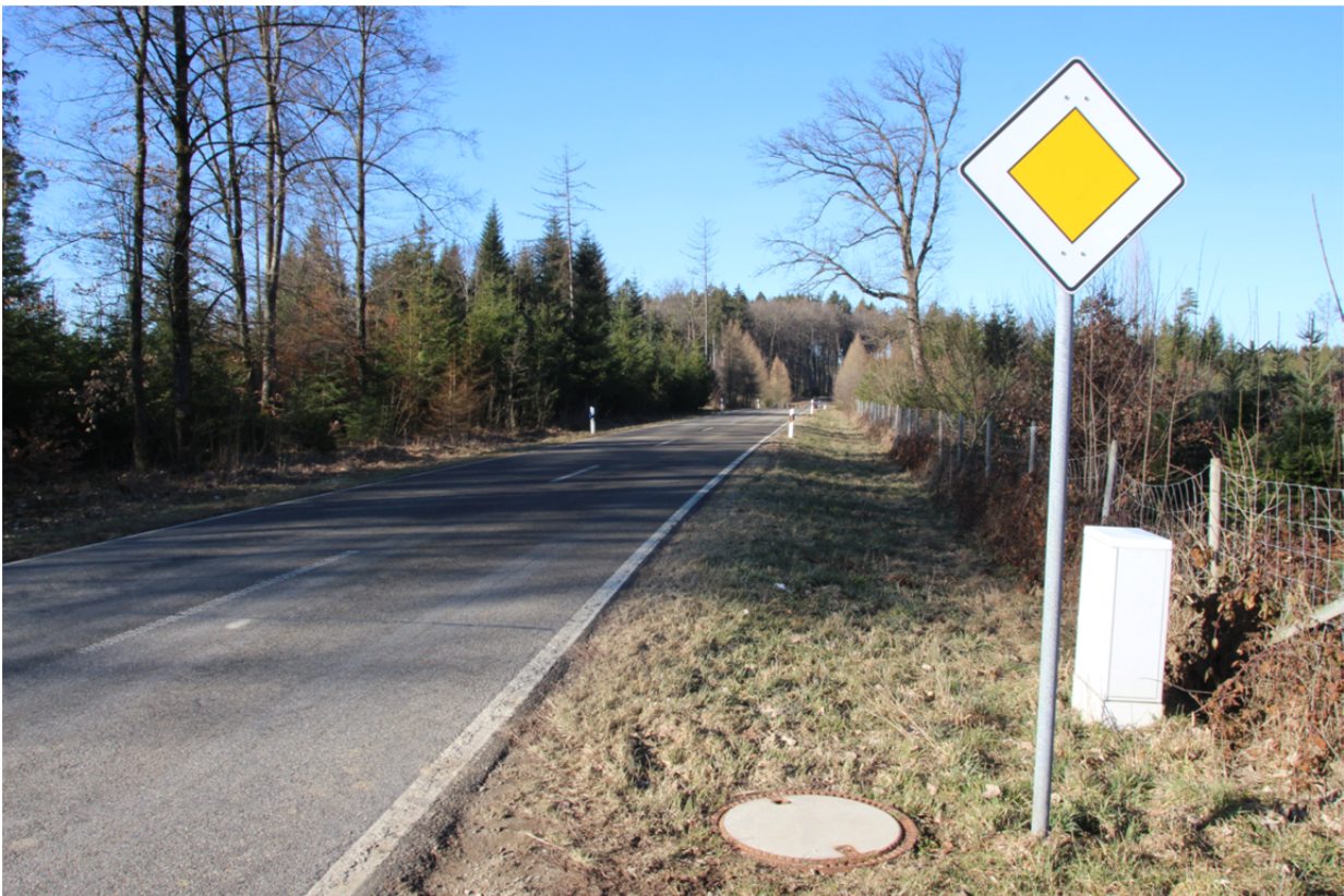
Bild 74 Messschacht, Schrank für Messtechnik, Blick Richtung Ortschaft Wald (hinter dem Wald, durch den die Straße führt, gelegen)
