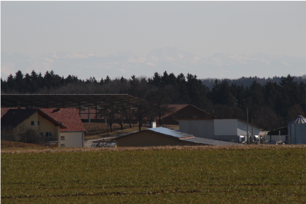
Bild 66 speisendes Biomasse-Blockheizkraftwerk (Zoom-Aufnahme)
