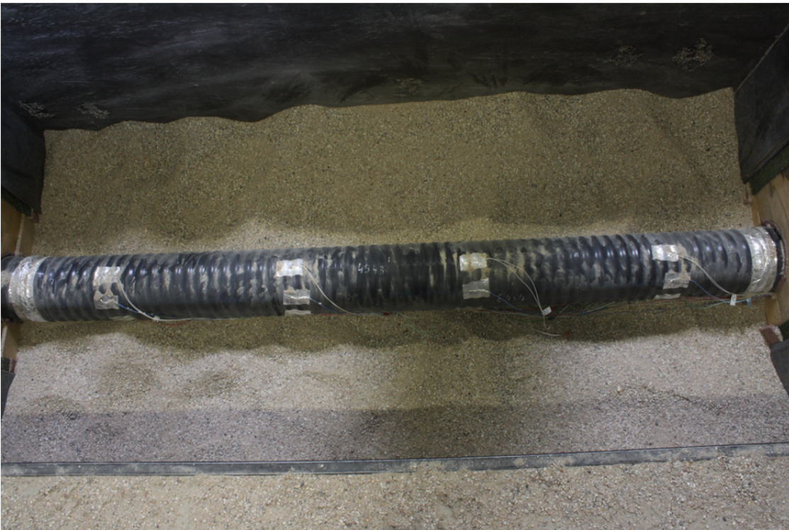
Bild 51 Freilegung nach einer Messung, flexibles Verbundrohr mit Mediumrohren aus vernetztem Polyethylen, mit applizierten Sensoren auf dem Außenmantel
